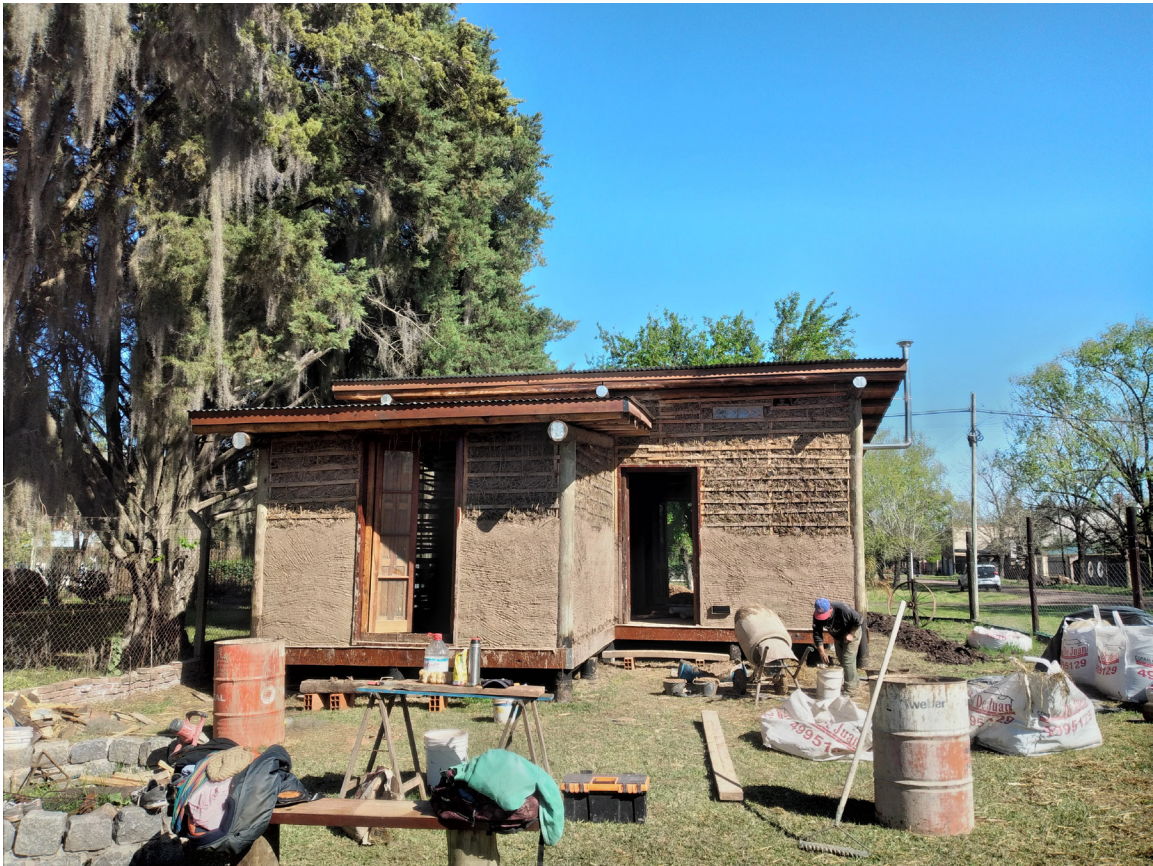
Figura 2. Casa construida con técnicas mixtas
