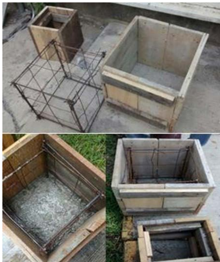
Figura 16. Cimbra y armado del macetero
