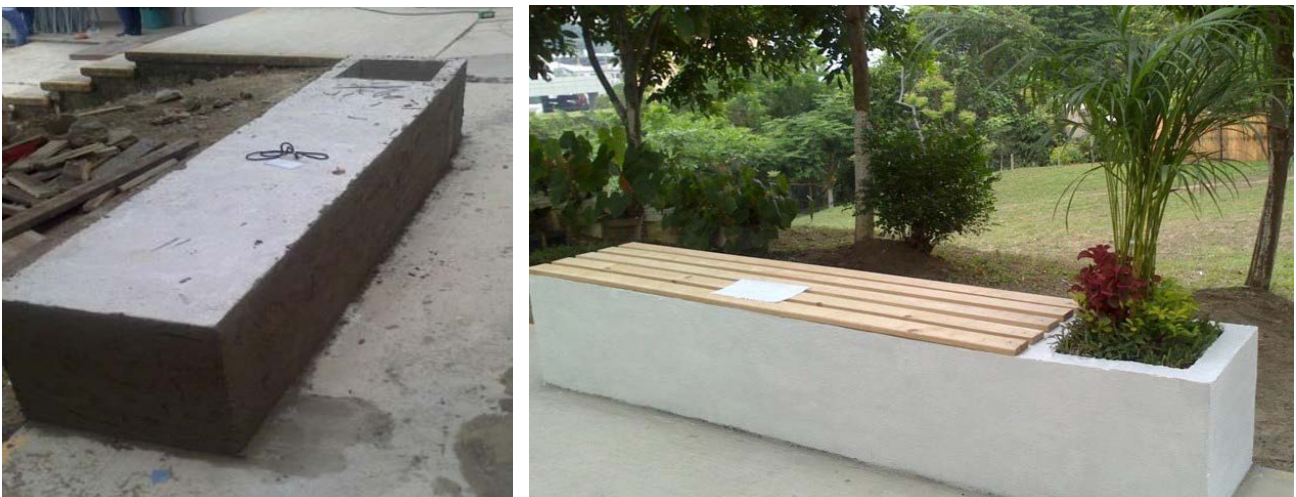
Figura 18. A) Banca en obra negra. B) Banca concluida con sus detalles finales
