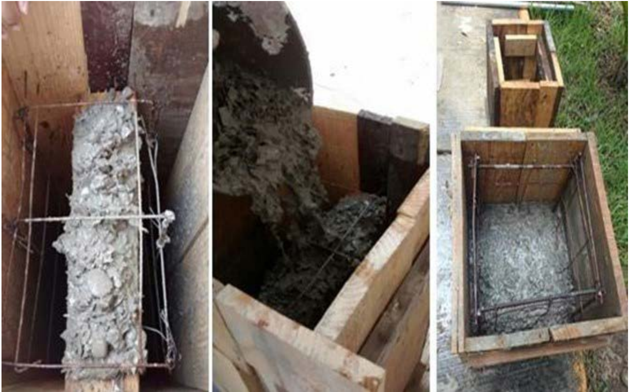
Figura 17. Vaciado de mezcla en el macetero
