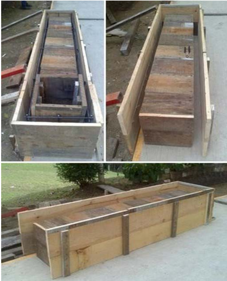
Figura 15. Proceso de armado de cimbras para la banca
