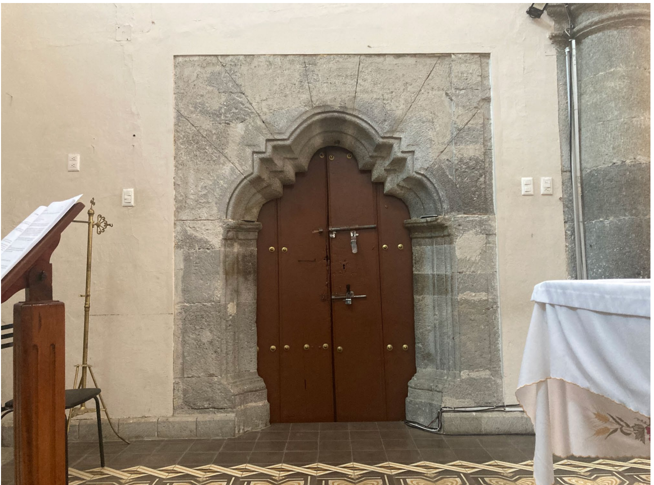
Figura 4. Portada de acceso a la sacristía desde el presbiterio del templo
