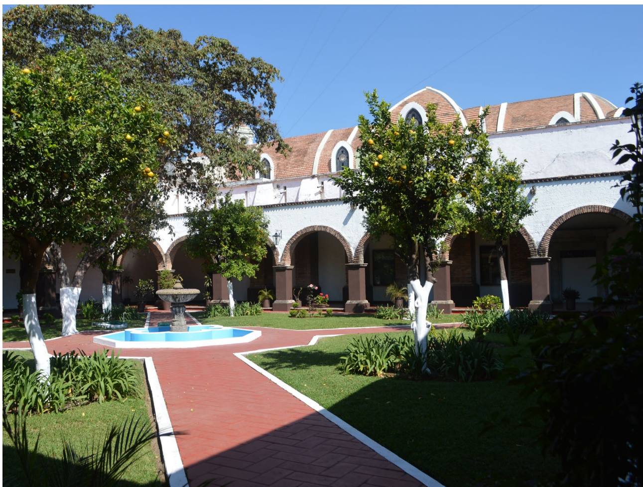
Figura 7. Paramento norte del claustro principal en el convento de La Cruz
