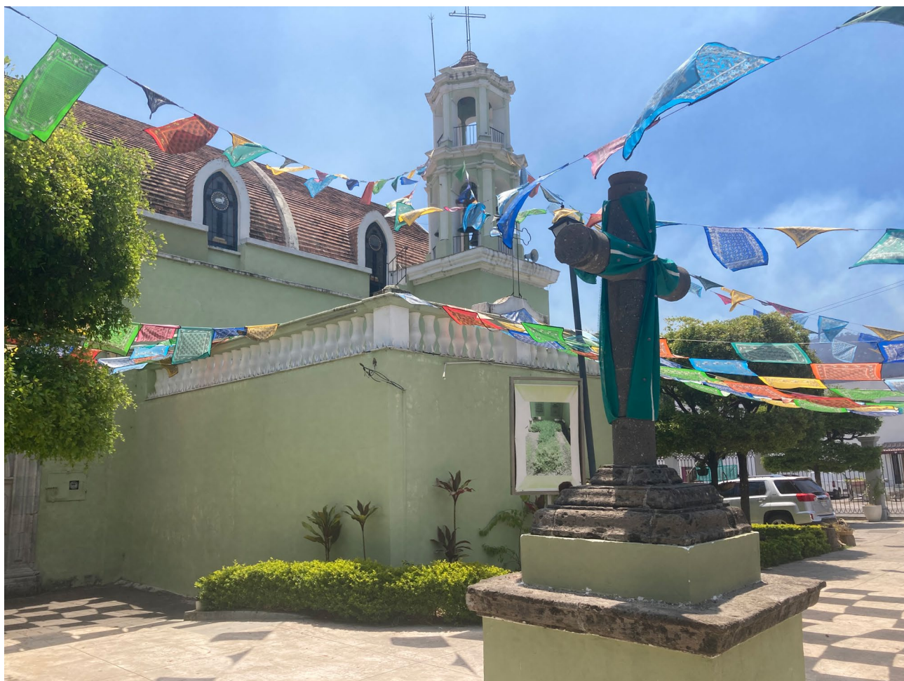
Figura 6. Las techumbres de la nave del templo
