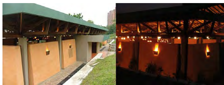
Figura 1. Muros en tapia, en el restaurante de la Universidad Adventista de Colombia.
