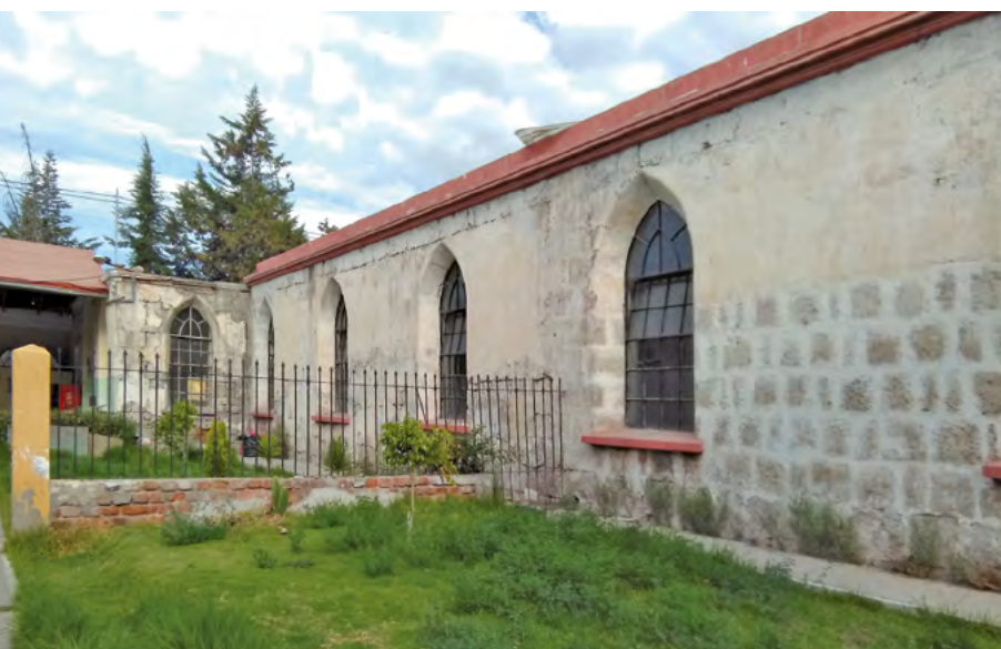
Figura 2. Vista exterior de la sala de hospitalización del hospital Goyeneche.
