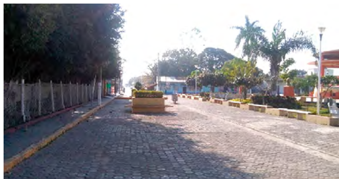
▲ Figura 5. Destrucción del inmobiliario urbano por el paso del huracán Grace. Fuente: elaboración propia (2021).
