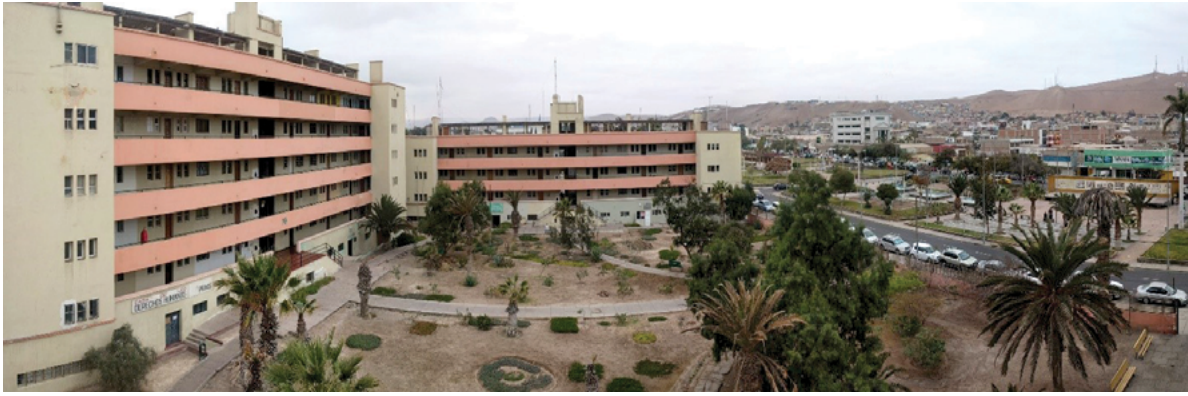
Figura 4. Vista de dos edificios colectivos de la Caja del Seguro Obrero, en la ciudad de Arica, y de la plaza de acceso con la avenida Doctor Juan Noé y el parque Carlos Ibáñez del Campo.
