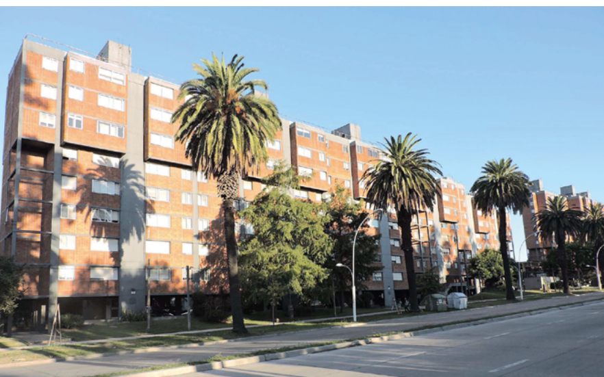
Figura 1. Complejo Habitacional Bulevar Artigas, a partir da Av. Bulevar General Artigas
