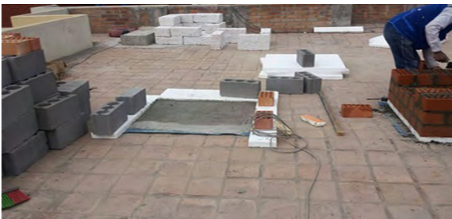
Figura 3. Aislamiento en cubierta de los módulos.
