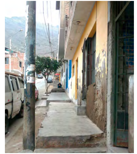
Figura 22. Grado de consolidación urbana: estado de la calzada y veredas.
