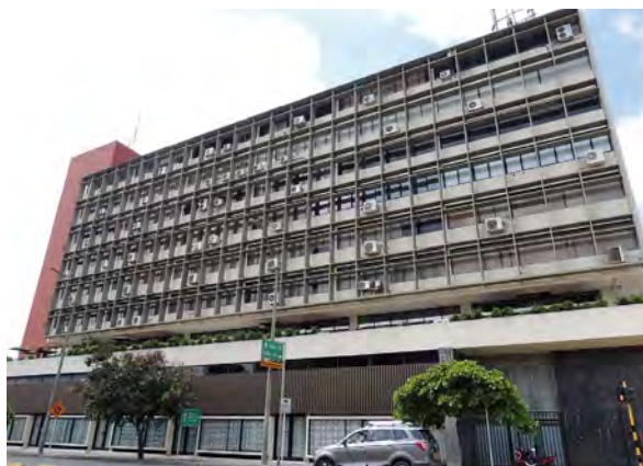
Figura 24. Edificio Belmonte, en Cali (1958).
