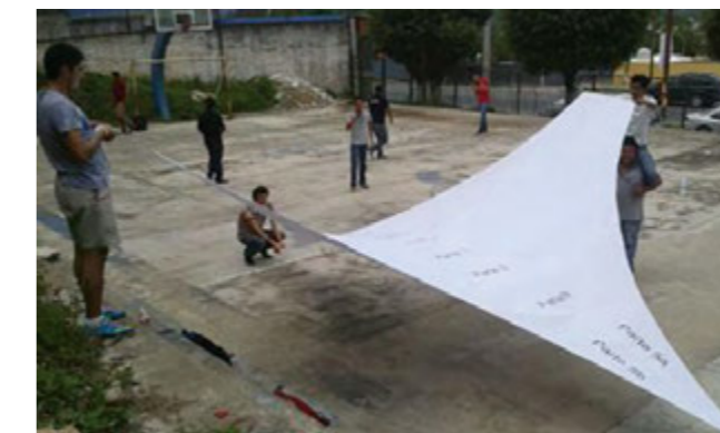
Figuras 39, 40, 41. Representación de la membrana dividida en secciones en las que se une la tela malosombra por medio de una costura industrial Fuente: Morales (2014b).
