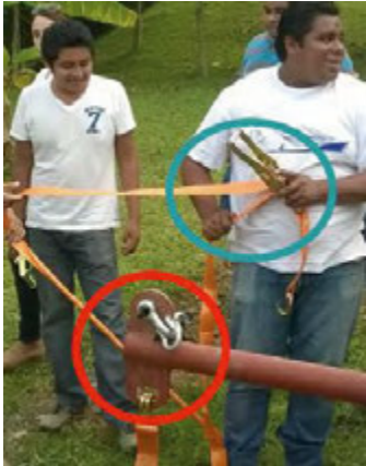
Figuras 45, 46, 47. Conexiones de refuerzo y accesorios de tensión para velaría Fuente: Morales (2014b).
