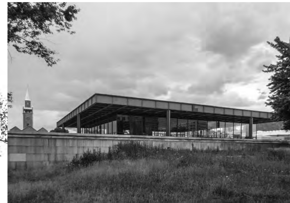
Figura 3. Nueva Galería Nacional de Berlín, último proyecto construido por Mies van der Rohe. Se evidencia la cubierta tectónica sobre el podio estereotómico
