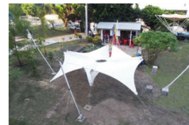
Figura 35. Conexiones diseñadas para el montaje Fuente: Morales (2013b).
