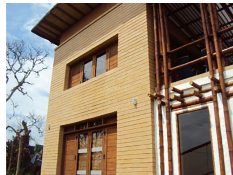
Figura 9. Fachada en BSC, bahareque y guadua Fuente: elaboración propia, 2014.
