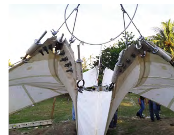
Figuras 32, 33, 34. Conexiones metálicas de la tenso-estructura Fuente: Morales (2013b).
