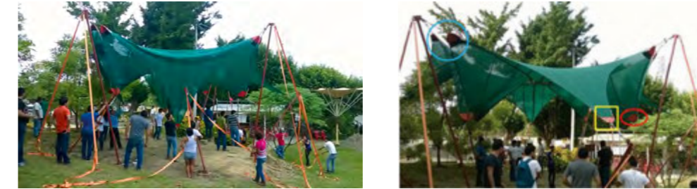
Figuras 48-52. Primer montaje de la velaría Fuente: Morales (2014b).
