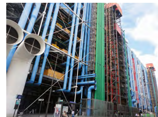
Figura 7. Centre Pompidou. Fachada posterior, sobre la rue du Renard / rue Beaubourg. Fachada posterior del Centre Pompidou, sobre la rue du Renard/rue Beaubourg, en la cual sobresalen los elementos en cuatro colores según su función: azul para instalaciones de climatización; amarillo para instalaciones eléctricas; verde para instalaciones hidráulicas; y rojo para elementos de circulación (escaleras mecánicas y ascensores).
