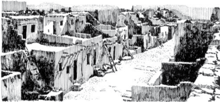
⊖ 7. Vista de las filas de casas escalonadas hasta tres niveles y separadas para evitar la sombra en invierno sobre las demás filas de casas, y sus muros de almacenamiento de calor
