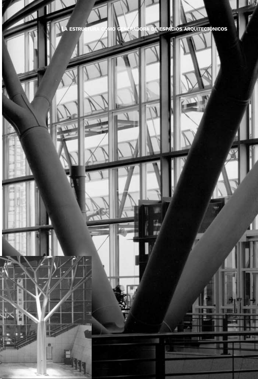
FOTO No. 4. Ramificaciones de la estructura del vestíbulo aeropuerto Stuttgart
