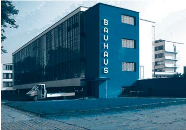
EDIFICIO DE LA BAUHAUS * Walter Gropius, Dessau, 1925-26
