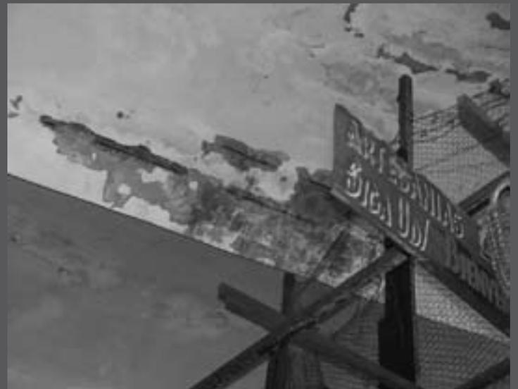
FOTO 11. MERCADO DE GIRARDOT EN 2006: El óxido en las bóvedas, numerosos cables eléctricos sueltos; fisuras y humedades acusaban ya un considerable grado de deterioro.
