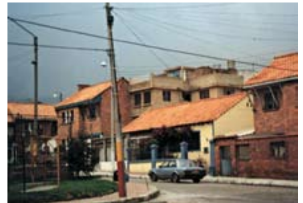
Figura 2 Destrucción de la tipología original. Fuente: Cubillos (2006) Trabajo de campo.
