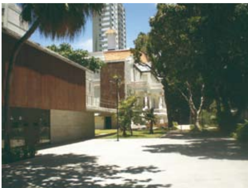
Figura 12. Prédio novo e ao fundo, prédio antigo. Foto do autor.
