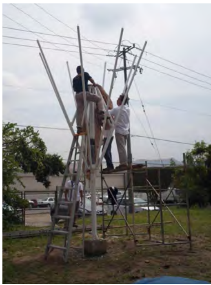
Figura 21. La manufactura en acero facilitó la construcción del paraguas retráctil, ya que por su alta resistencia a la tracción puede estabilizar la tensión que generará el manto sobre ella Fuente: Morales (2013b).
