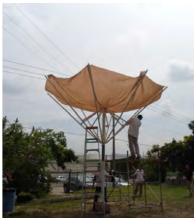
Figura 22. Proceso constructivo del prototipo de paraguas retráctil, desde la cimentación hasta el montaje, y desplegado de la vela en la estructura, esto se desarrolló en la Facultad de Arquitectura de la Universidad Veracruzana, Campus Poza Rica Fuente: Morales (2013b).
