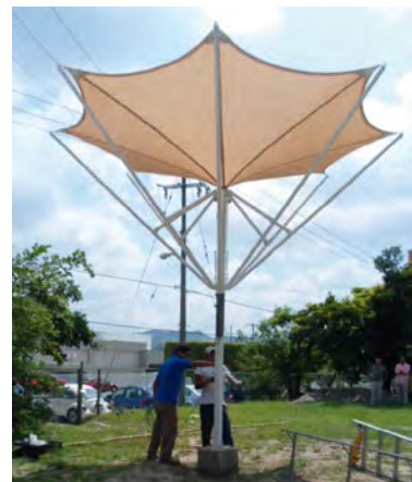
Figura 22. Proceso constructivo del prototipo de paraguas retráctil, desde la cimentación hasta el montaje, y desplegado de la vela en la estructura, esto se desarrolló en la Facultad de Arquitectura de la Universidad Veracruzana, Campus Poza Rica Fuente: Morales (2013b).
