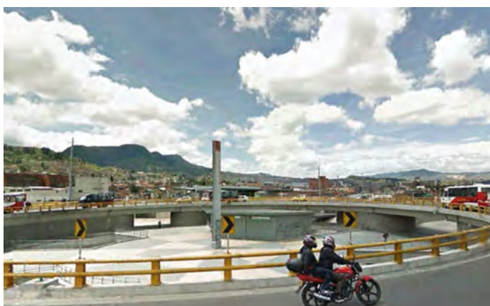
Figura 10. Estación Bicentenario, troncal Carrera 10 Foto: Google Street View, 2015.
