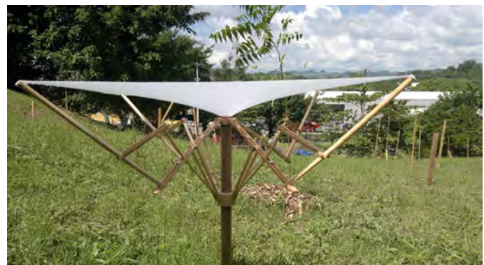
Figura 7. La cubierta textil ayuda a rigidizar el sistema plegable del paraguas, generando la forma final del modelo
