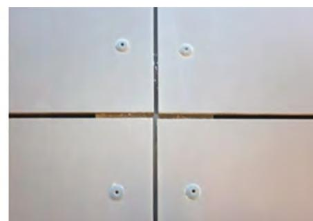
Cámara cerrada. Ventilación por juntas abiertas
