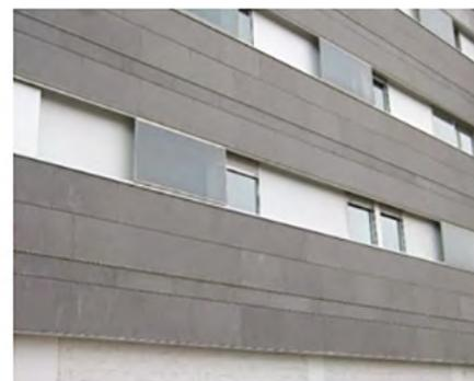
Cámara cerrada. Ventilación por juntas abiertas
