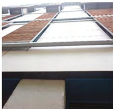
Cámara cerrada. Ventilación por juntas abiertas
