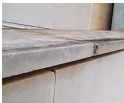
Cámara semi abierta - Ventilación por apertura superior
