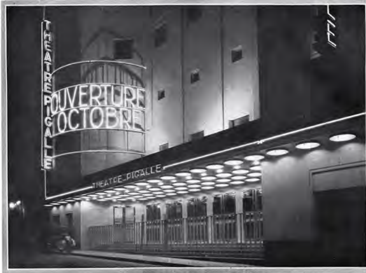
Fig. 1. — Façade du théâtre Pigalle.
