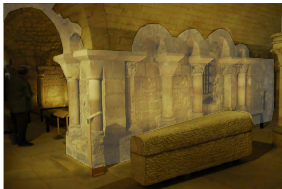
Illustration 2. Raccord neuf-ancien dans la crypte Source : Photographie de l'auteur.
