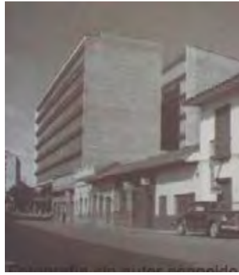
➤ Figura 19. Edificio Miguel de Aguinaga, carrera Carabobo dirección norte-sur (fotografía sin autor)
