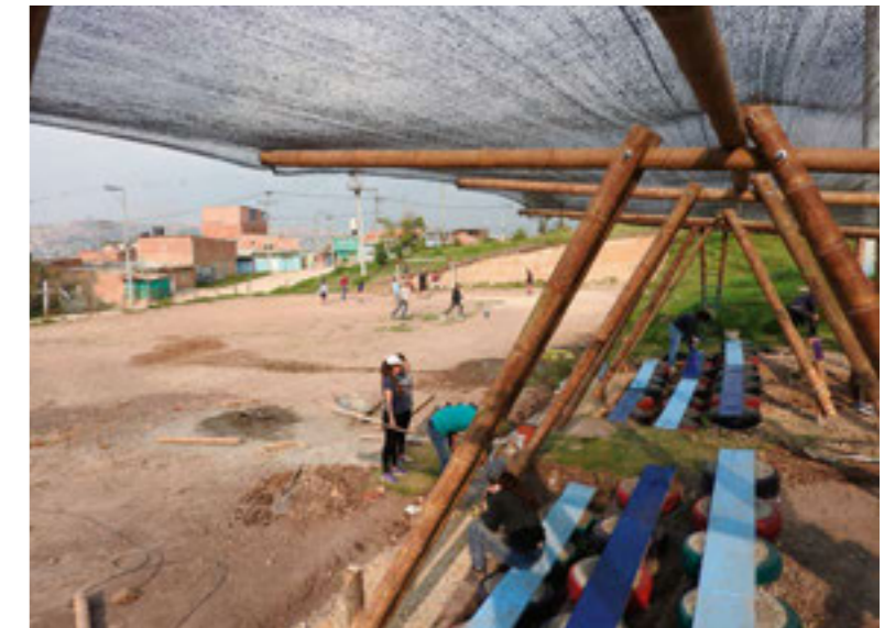
Figuras 17 a 20. Construcción de una gradería en la cancha del barrio Villanueva Fuente: Hernando Carvajalino Bayona, 2017.
