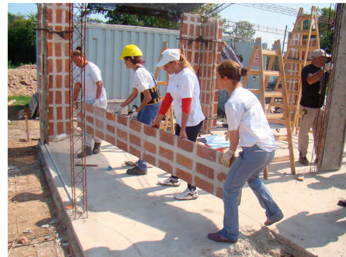
Figura 3. Beneficiarias del programa “Ellas hacen”, acompañadas por técnicos del MDS y representantes del CEVE montando una placa BENO sobre estructura UMA, en La Plata, Buenos Aires (Argentina).
