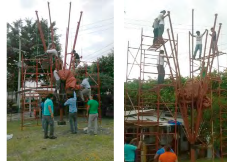
Figuras 67 a 72. Posteriormente se colocó la membrana pretensada al paraguas, con ayuda de dos andamios armados de 9 m, en cada conexión se colocó un regulador y un grillete de 1/2", que sirve de articulación flexible a la hora del despliegue Fuente: Morales (2013).
