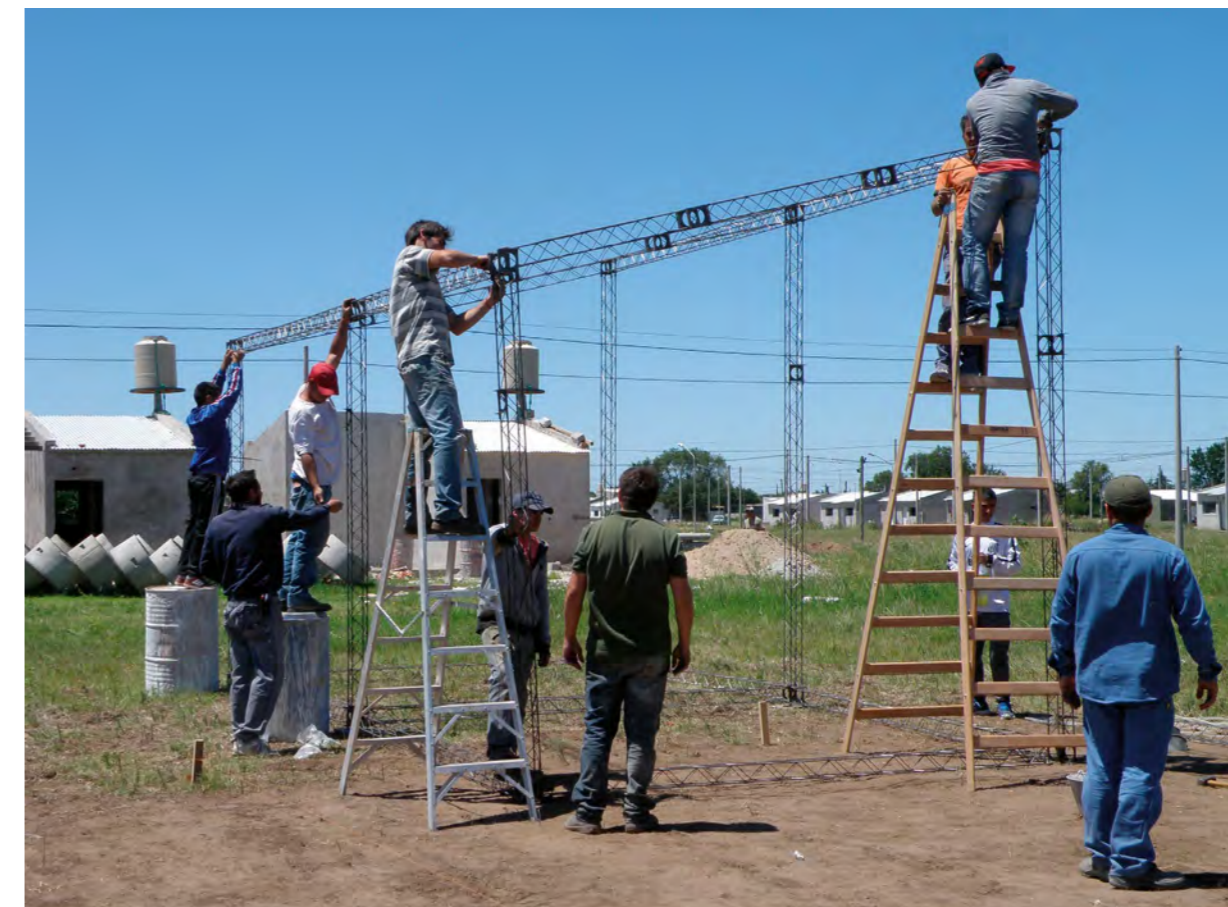
Figura 5. Cooperativistas junto a participantes del CEVE y representantes del IMV realizando el ensamblado de la estructura metálica del prototipo en la ciudad de Río Cuarto Fuente: CEVE, diciembre de 2014.
