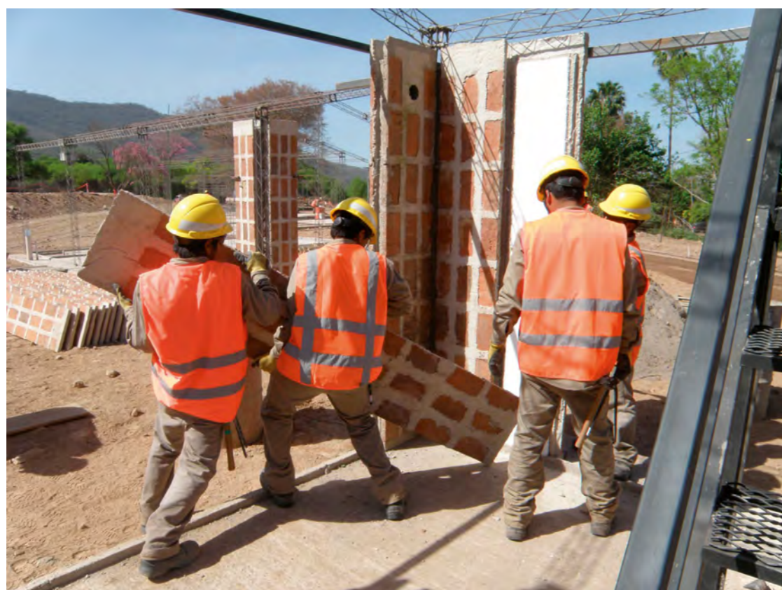
Figura 4. Montaje de las placas BENO sobre estructura UMA en Puesto Viejo Fuente: CEVE, noviembre de 2015.
