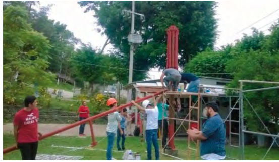
Figuras 53 a 63. Posteriormente se conectan los postes cables a los miembros centrales que articulan el movimiento del sistema transformable, cada conexión se hace en simetría para compensar el peso de la estructura Fuente: Morales (2013).
