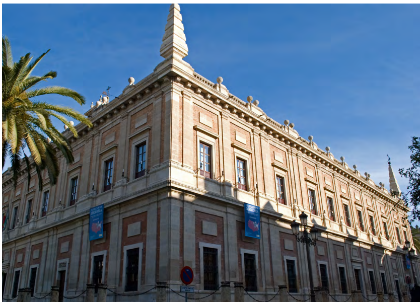
Figura 1. Archivo de Indias, en Sevilla. Antigua Casa de Contratación. Fuente: Anual (2009).
