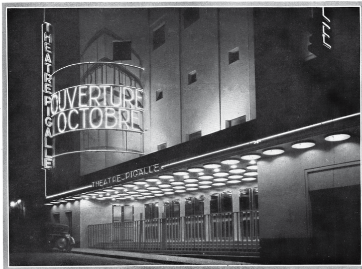
Fig. 1. — Façade du théâtre Pigalle.
