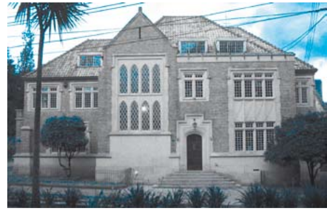
VIVIENDA TRANSFORMADA EN SU USO A PARTIR DE DIVERSAS ACTIVIDADES, CALLE 36 ENTRE CARRERAS 5 A Y 6
