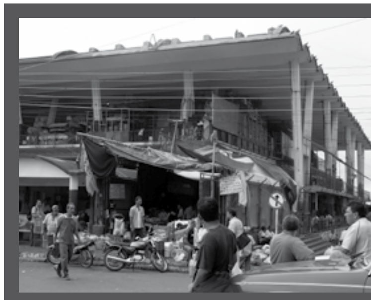
FOTO 2. PLAZA DE MERCADO, GIRARDOT. LEOPOLDO ROTHER; DISEÑO ESTRUCTURAL DE GUILLERMO GONZÁLEZ ZULETA, 1946. Adecuada al clima, a cómo mercar y a la idiosincrasia de vivanderos y compradores.
