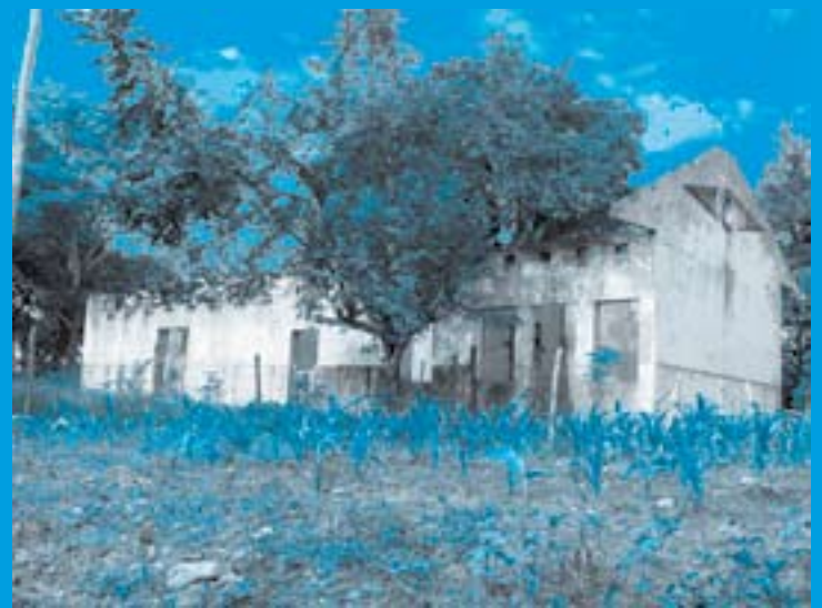
FOTO 7. ESTACIÓN DE FERROCARRIL FORTALECILLAS, HUILA, MOLINA VEGA, 1936. Además de construida obra diferente al proyecto, claramente moderno, el abandono hizo su labor.
