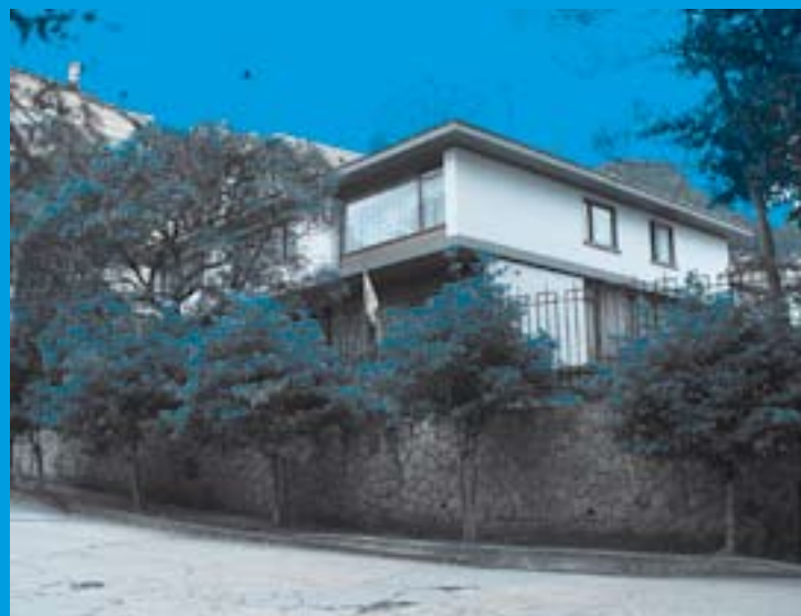
FOTO 4. CASA LOCALIZADA EN EL BARRIO ROSALES DE BOGOTÁ, CARRERA 3 CON CALLE 75, DEMOLIDA. Con otras obras destruidas de entonces, desaparecen los aportes del movimiento moderno.
