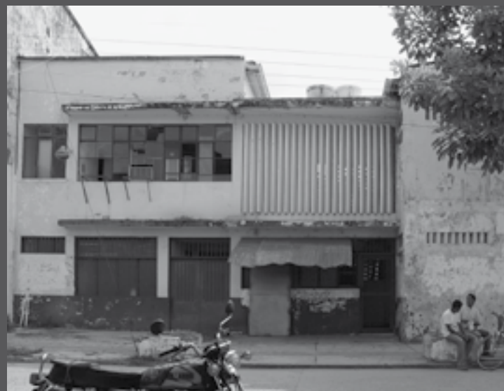
FOTO 9. EDIFICIO DE CORREOS DE EL GUAMO, TOLIMA, R. FRANCO ISAZA, 1949. El abandono desde (ca) 1987 revela que además debió tener buena calidad constructiva y estructural.
