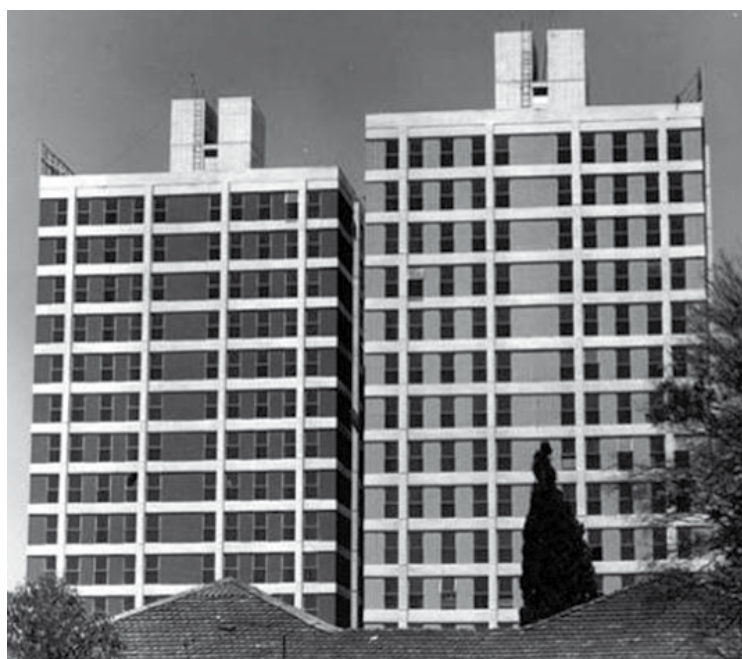
Figura 4. Conjunto de edificios Modular Coronet, calle Cancioneiro Popular 116, barrio Santo Amaro, São Paulo, 1973
