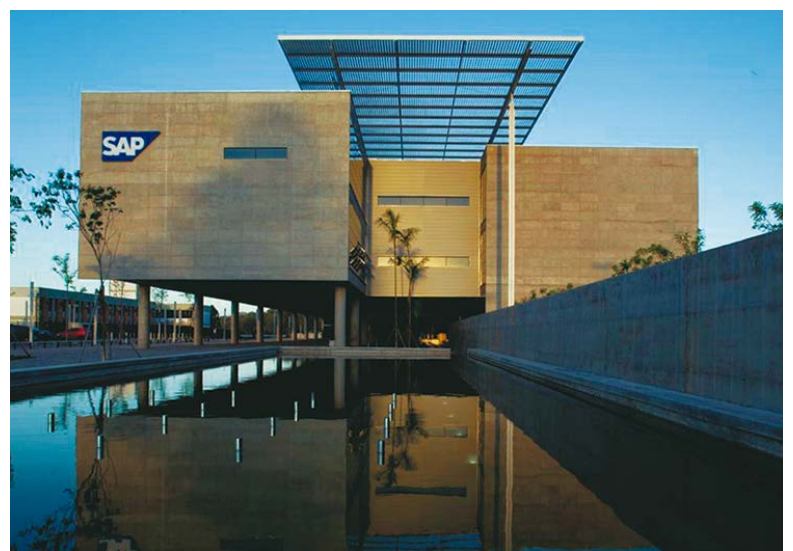
Figura 24. Edificio sede para las oficinas del SAP (Global Service Center), Campus Unisinos, São Leopoldo, Rio Grande do Sul, 2011. Fuente: Almeida (2014).
