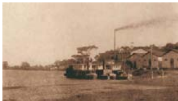
Figura 5. Conjunto KKKK na década de 1930.
