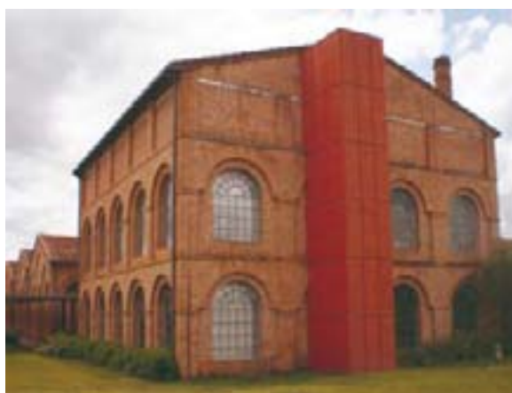
Figura 8. Prédio do Engenho após a intervenção. Foto do autor.
