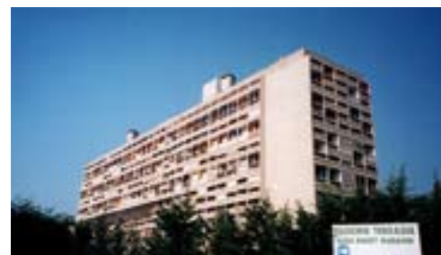
Unidad Habitacional de Marsella. Le Corbusier (1952). Parte de objetos conocidos, aprovechando el potencial simbólico de las formas, mantiene el significado implantado en un contexto nuevo.
