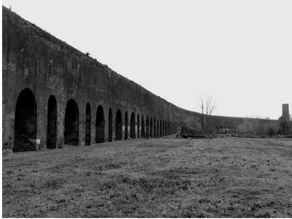
Figura 4. Vista del acueducto de Claudio que caracteriza el paisaje de la Unidad de Libera
