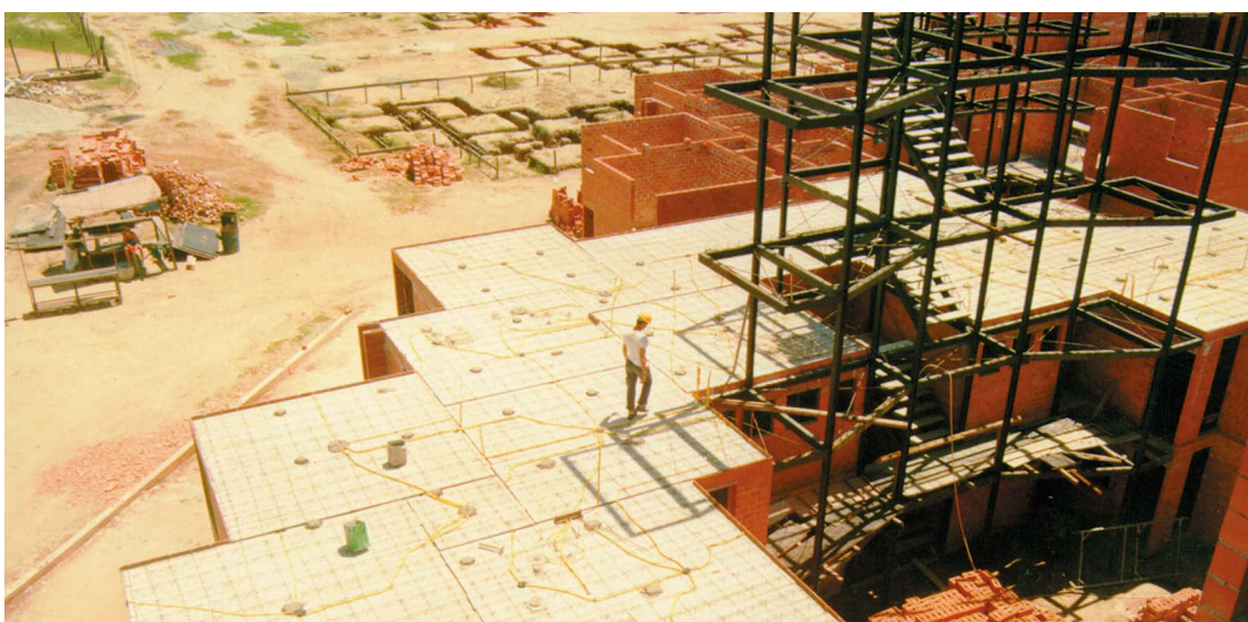
Figura 7. Escaleras metálicas y mampostería estructural en la obra del COPROMO (SP)
