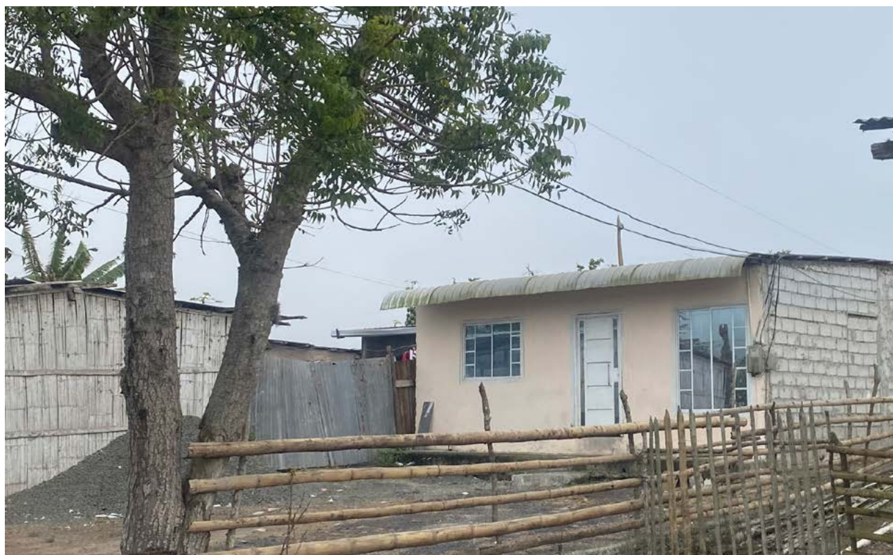
Figura 9. Vivienda rural con materiales de construcción predominantes en las zonas rurales del cantón Chone, en la provincia de Manabí
