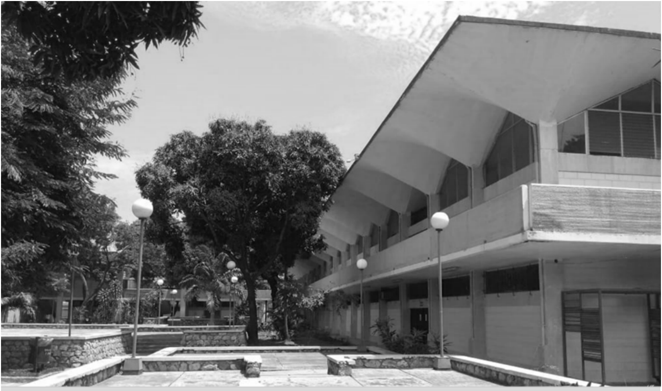
Figura 11. Paraboloides de la cubierta de bloque de aulas de la Facultad de Arquitectura y Urbanismo
