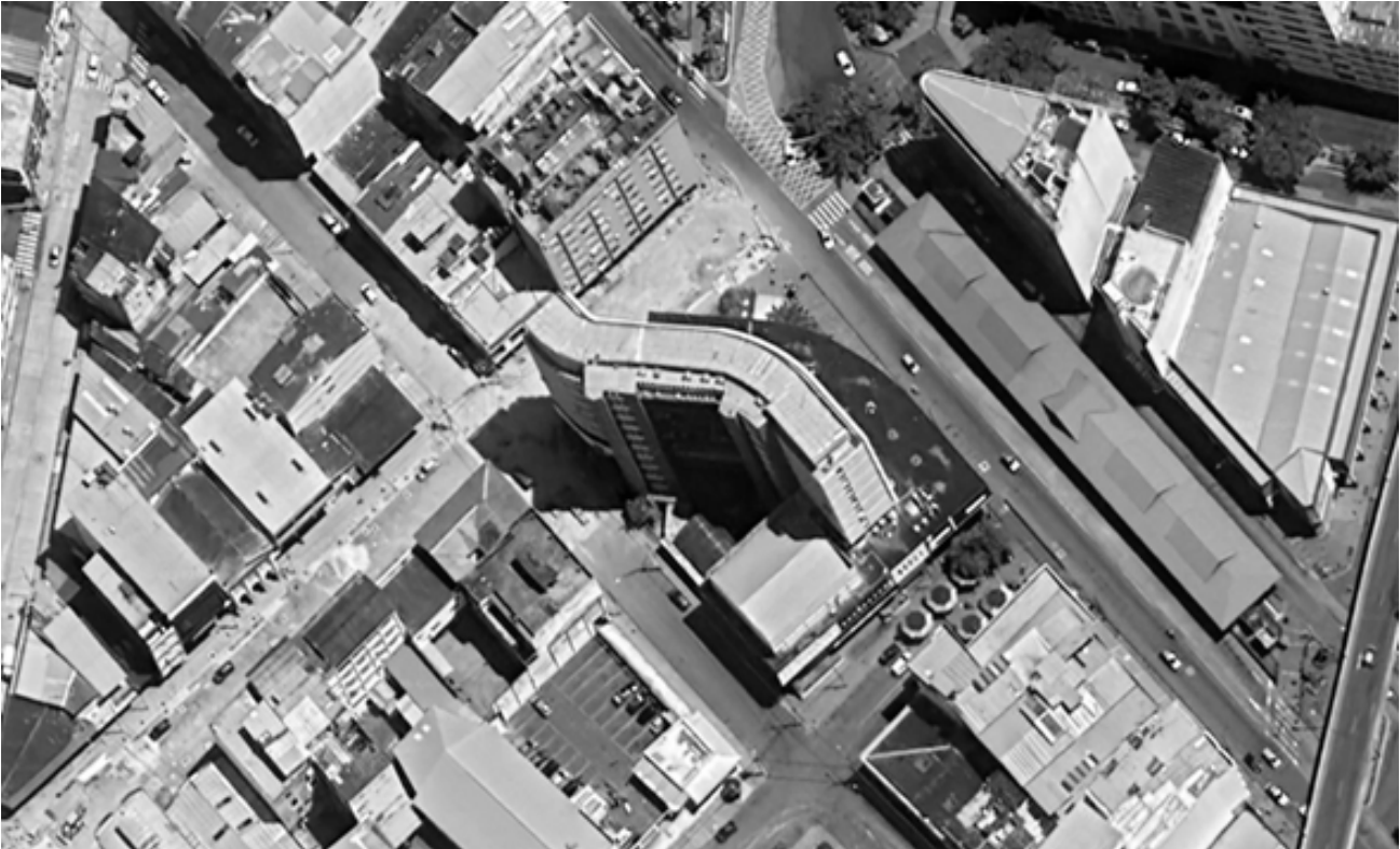
Figura 8. Edificio de la Caja del Seguro en Guayaquil
