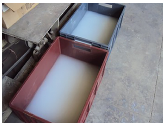
Figura 12. Preparación del agua con cal para el curado.
