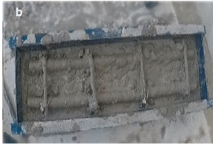
Figura 7. a) Colocación del armado; b) Vaciado del molde.
