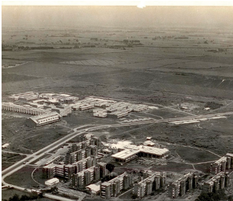
Figura 2. Campus de la Universidad del Valle durante su construcción, en 1971
