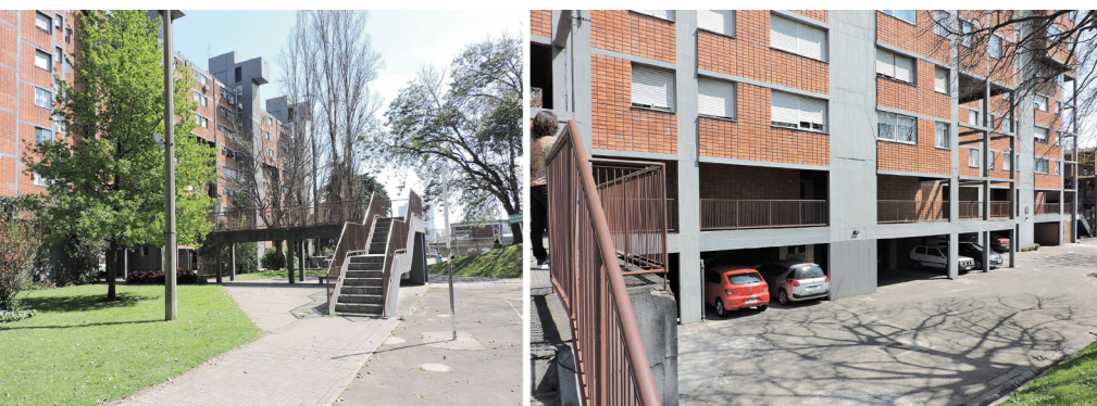
Figura 10. Ruas elevadas do conjunto
