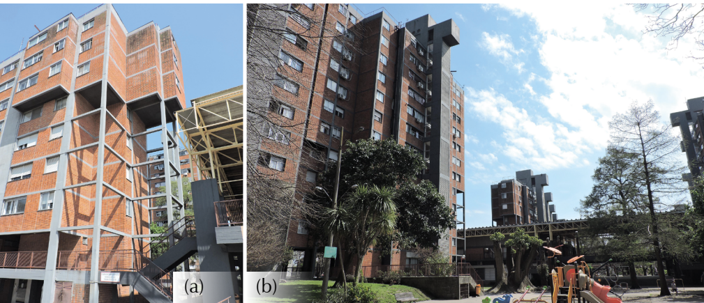
Figura 8. Vazios no preenchimento da estrutura do conjunto (a) e espaço coletivo e edifícios do conjunto (b)
