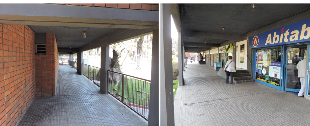
Figura 11. Ruas elevadas do conjunto
