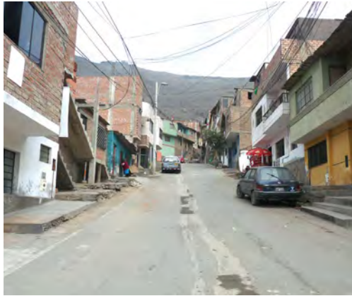
Figura 21. Grado de consolidación urbana: estado de la calzada y veredas.
