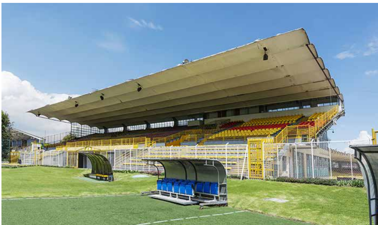
Figura 14. Vista actual de la tribuna principal del Hipódromo de Techo Fuente: elaboración propia, 2018, CC BY.
