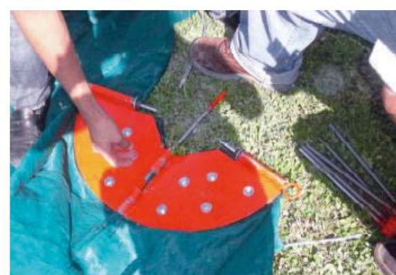
Figuras 42, 43, 44. Montaje de las uniones metálicas en la membrana Fuente: Morales (2014b).
