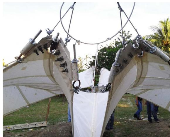
Figuras 32, 33, 34. Conexiones metálicas de la tenso-estructura
