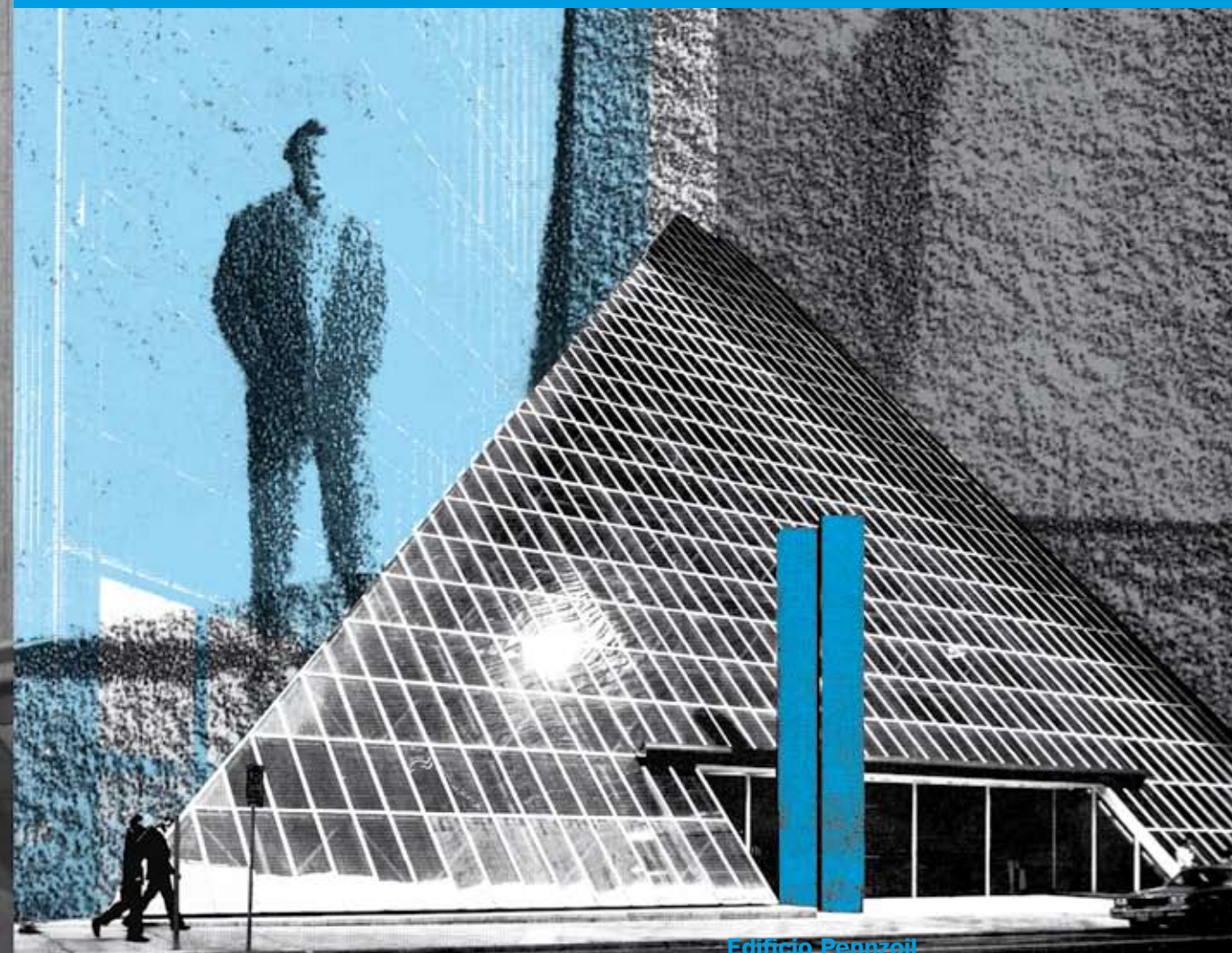
Edificio Pennzoil Houston, 1970-1976
