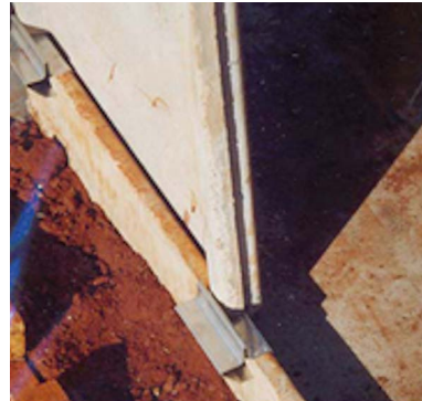
Figura 12. Processo de montagem das divisórias de argamassa armada
